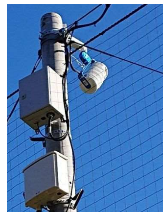
カメラ設置写真
